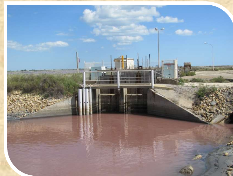
Ponton sur un des étangs avec du sel cristallisé sur les pieds et sas de pompage pour le transfert de la saumure entre étangs
