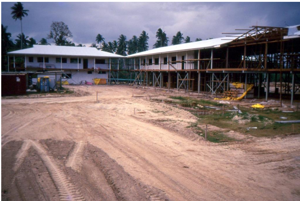
IV PNG 13 : Tavilo (1998). Le corps central du campus du CCRI, en construction, prend forme (à l'arrière-plan, le bâtiment de la pathologie quasiment terminé).
