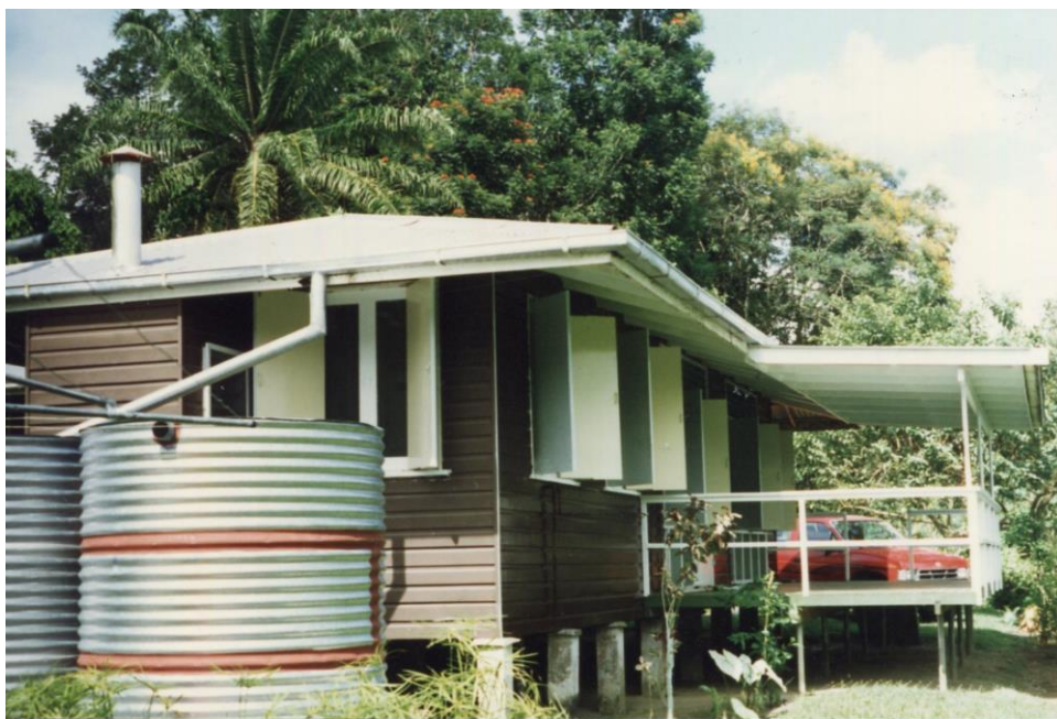
IV PNG 09 : Keravat (1996). Case m'ayant été attribuée par le LAES. Les water-tanks reliés aux gouttières sont d'importants réservoirs d'eau fragilisés sinon mis hors d'usage par les balancements du liquide générés par les tremblements de terre, ce qui entraîne la rupture des soudures.
