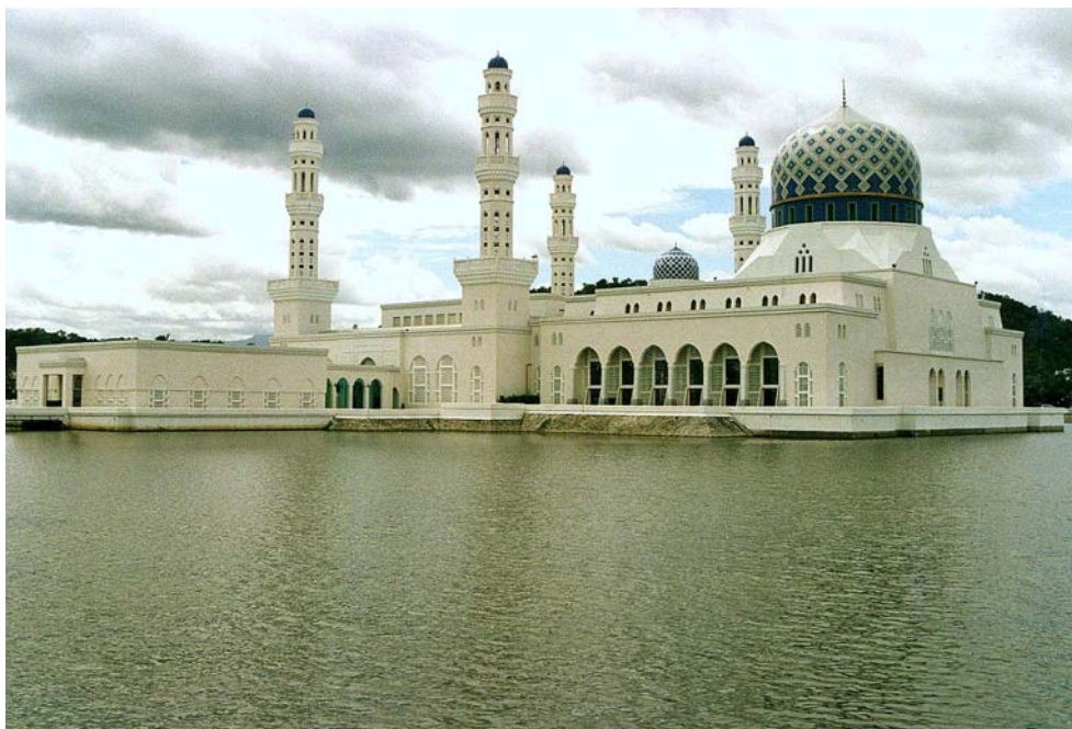
IV Asie, Kota Kinabalu 07 : Vue générale de la mosquée Masjid Bandaraya située en banlieue nord/nord-est en bordure de mer et sur une petite lagune aménagée en bassin (1999).
