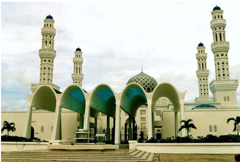
IV Asie, Kota Kinabalu 06 : Entrée somptueuse de la mosquée Masjid Bandaraya avec ses cinq arcades monumentales et ses quatre minarets soulignant les quatre coins cardinaux (1999).
