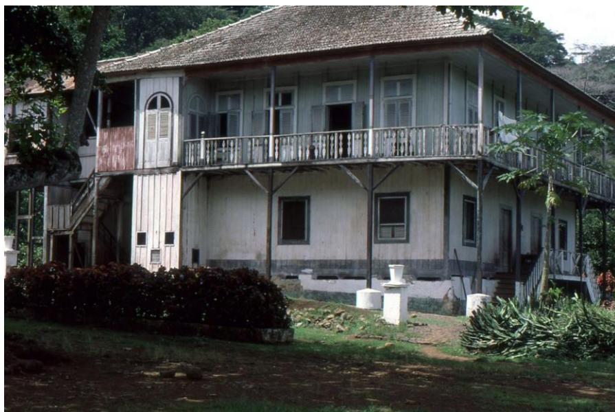
III ST. 13 : Roça de São Nicolau (São Tomé, 1985), galeries à balustres plates découpées.
